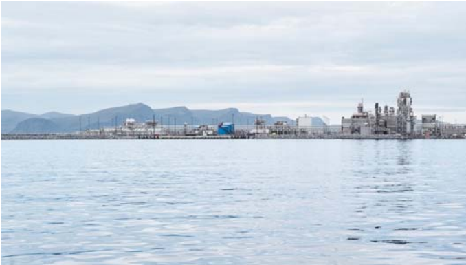
The Hammerfest LNG plant at Melkøya. (Photo: Øivind Haug / Equinor ASA)
